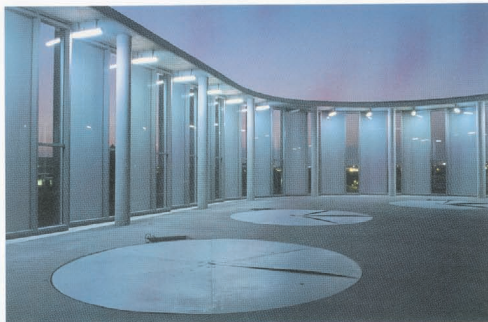
En haut, salle des plateaux de style, les rampes d'éclairage Thorn bi-tubes à grilles de défilement assurent la transition avec la lumière du jour. En bas, salle de présentation: reconstitution intégrale des lumières extérieures
