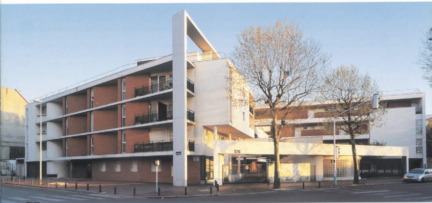
>>> Les effets structurels et plastiques du béton inscrivent l'îlot dans la ville.
